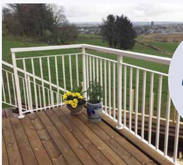
Rekkverk hvitlakkert på terrasse.
