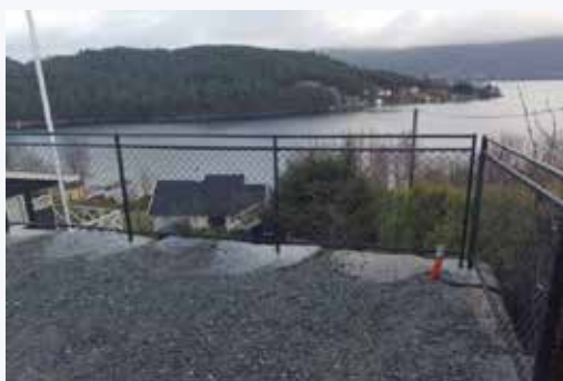
Flettverks rekkverk Robert.
