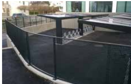
Sykkelparkering lakkert strekkmetall aluminium
