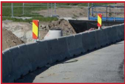
Anleggsrekkverket sikrer en trygg arbeidsplass for de som skal utføre arbeid langs vei eller andre utsatte plasser.
