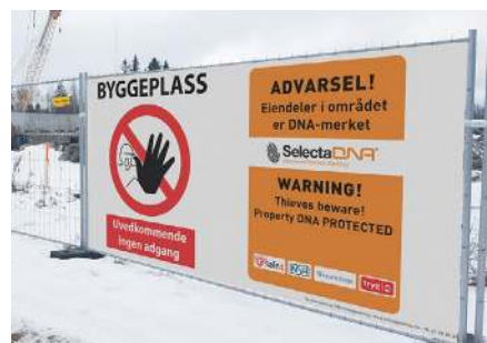
Bruk av dekkduk gir god profilering/informasjon. På grunn av lite luftgjennomstrømming kreves ekstra sikring slik at de ikke velter.
