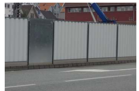
Tette byggegjerder hindrer innsyn til byggeplassen og er perfekte til bruk i bystrøk. Gjerdene gir stort vindfang, og god sikring er påkrevd.
